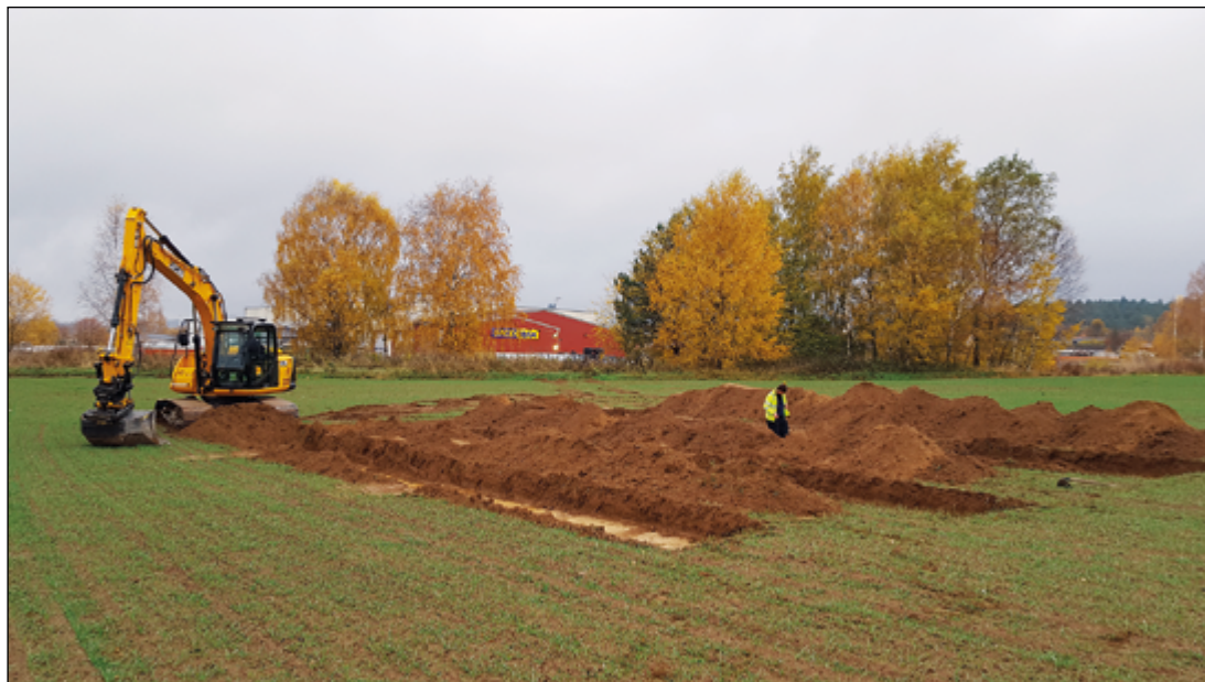
Figur 4. Förundersökningen genomfördes med hjälp av maskingrävda schakt, tätt placerade inom de två aktuella ytorna. Nina Balknäs inspekterar ett av de tre sydligaste schakten i det större, västra området. Foto från nordväst av Leif Karlenby.
