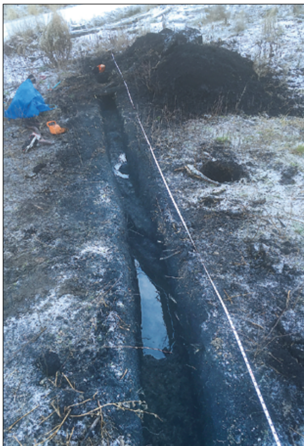
Figur 9. Sektionen som grävdes genom anläggningarna. Centralt i schaktet ligger bevarade trästockar. Foto från söder.
