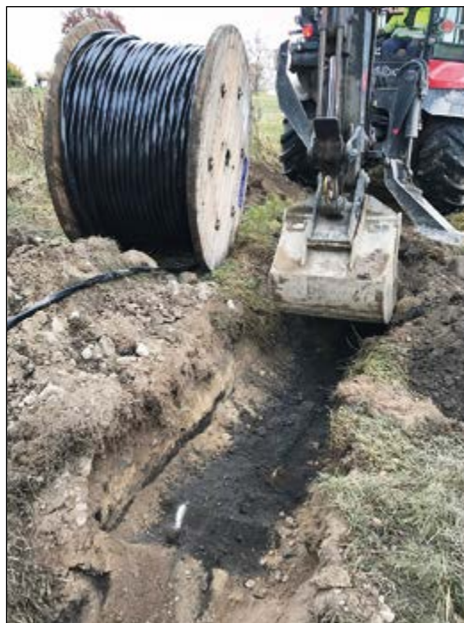
Figur 23a) Lagret A14 framträder vid schaktning. Foto från väster.
