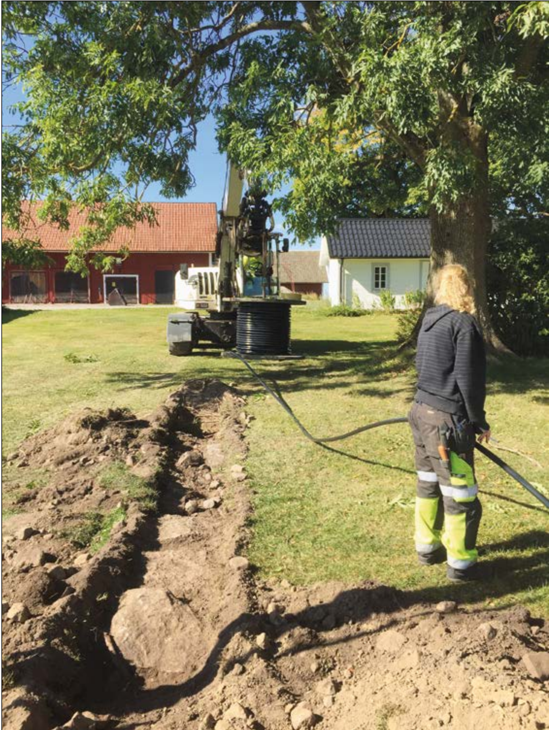
Figur 38. Sydvästra delen av schaktet. I förgrunden synsstensyllen A307. Foto från öster.
