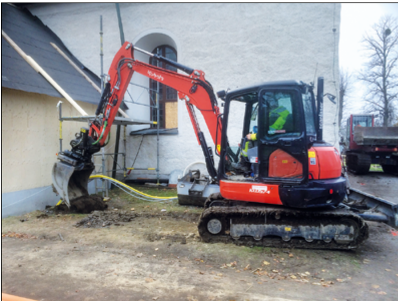
Figur 5. Första skoptaget. Start vid tillbyggnaden.
