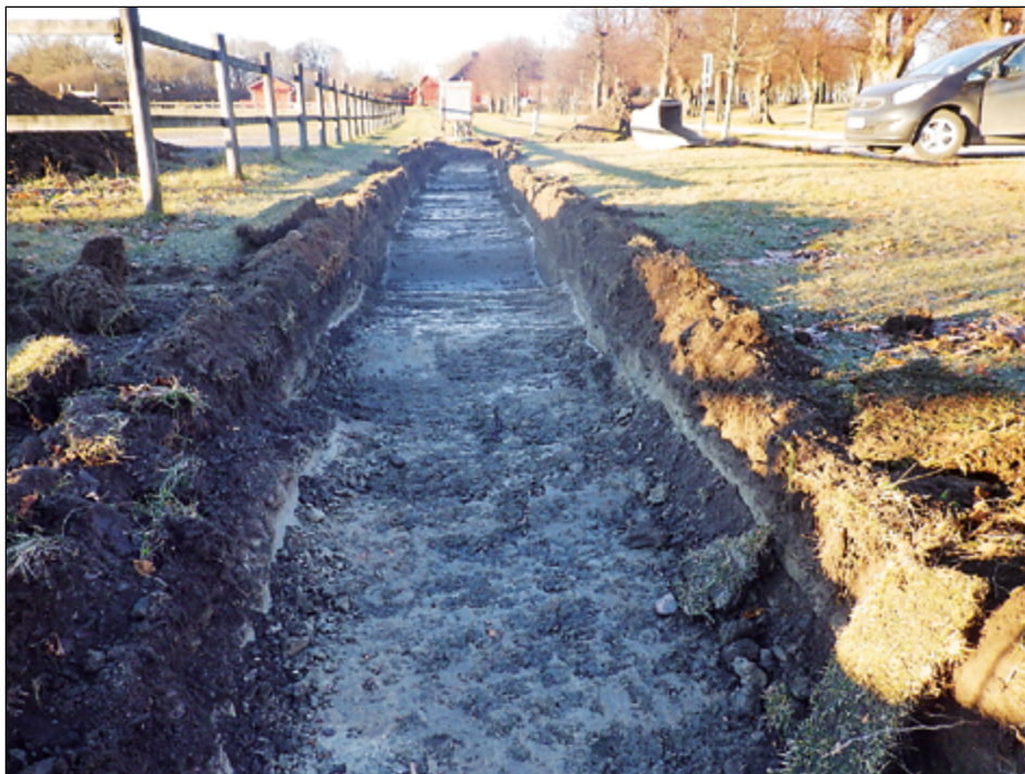
Figur 8 och 9. Schakten där den orörda leran kan ses i botten. Foton tagna av Arkeologgruppen AB.
