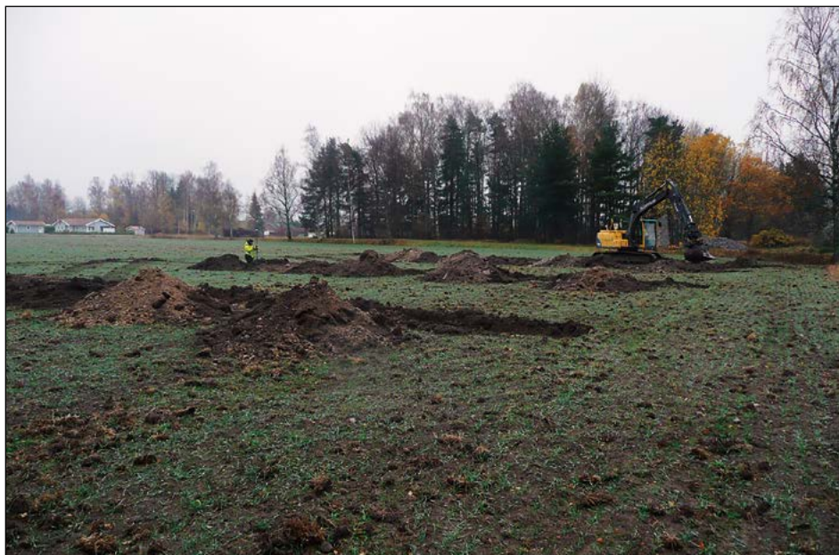
Figur 7. Vy över schakten på den östra sidan av Moholm. Foto av Leif Karlenby från norr.
