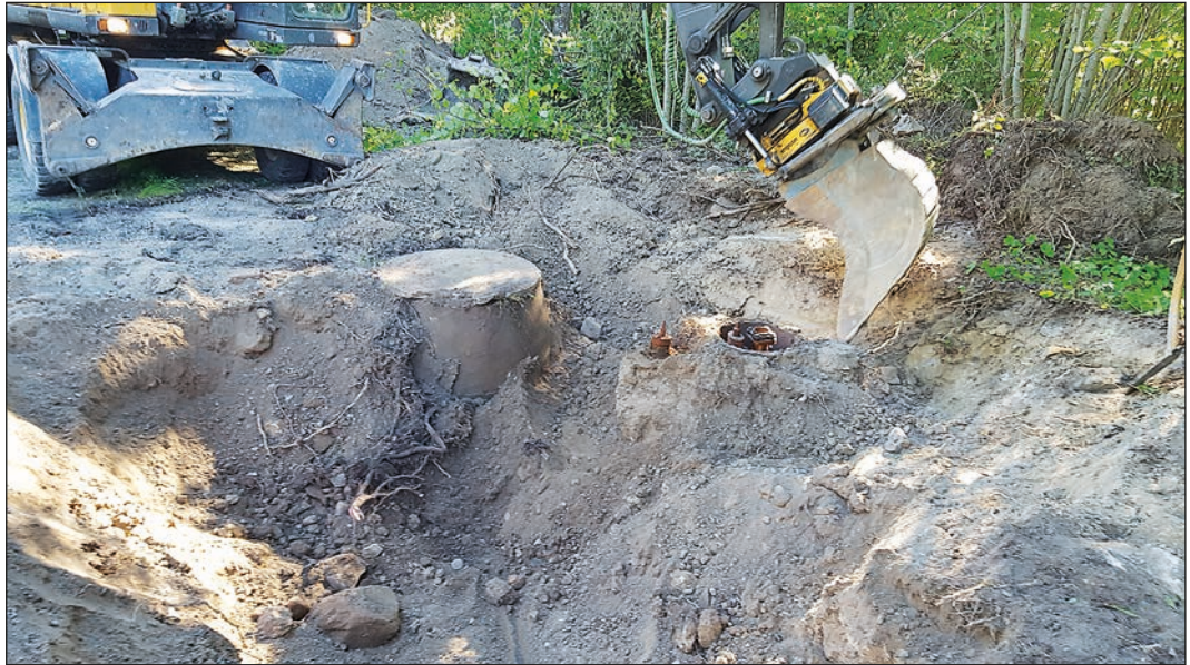
Figur 3. Utgrävning av tidigare nedstigningsbrunn och brandpost. Foto från nordväst av Leif Karlenby.
