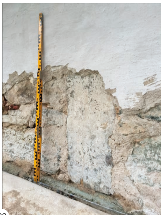
Figur 21. Hörnet på medeltida sockel och murverk utmed långhusets norra mur. Foto från nordväst av Nina Balknäs.
