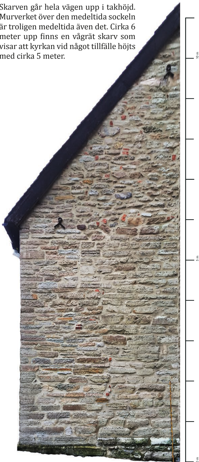
Figur 22. Långhusets västra mur. Både den lodräta och den vågräta skarven syns tydligt. Fotomontage från nordväst av Nina Balknäs. Skalan är ungefärlig.
