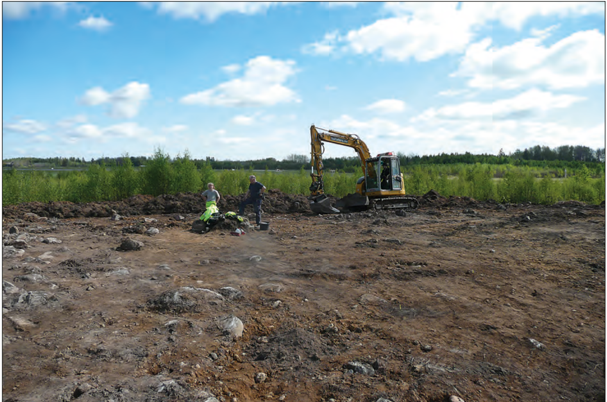
Figur 4. Färdigschaktat! Vy över det mittersta partiet av Täby 19:1-2. Marken var där relativt stenfri utan att vara "plockad". I anslutning till ytan fanns inga röjningsrösen. Nordväst om ytan (vänster utanför bild) fanns rösen och marken var avgjort mer stenig. Foto från söder av Johnny Rönngren.
