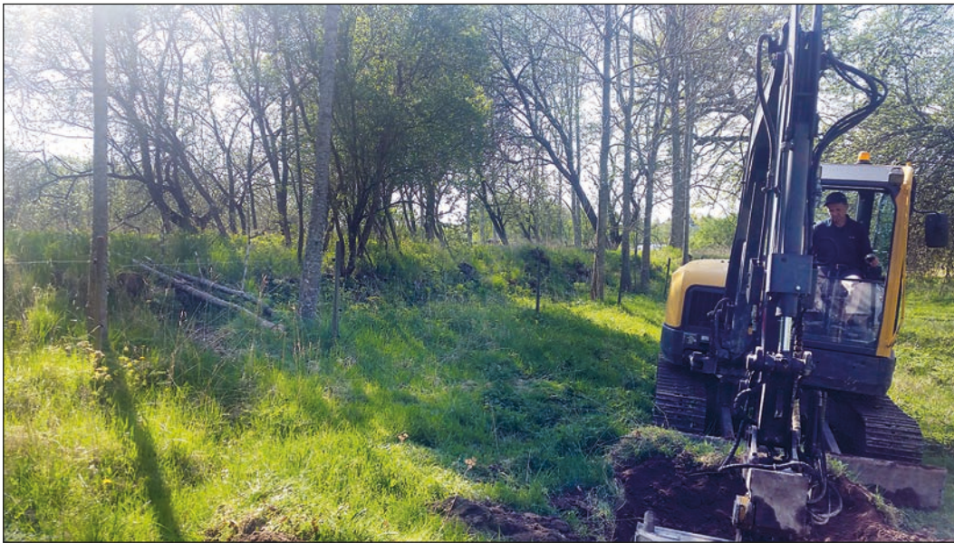
Figur 4. Schaktning i den norra delen av utredningsområdet, som var beläget strax väster om trädgårdsanläggningarna från 1800-talet. Notera att trädgården varit kraftigt terrasserad i förhållande till området i väster. Foto från norr av Leif Karlenby.
