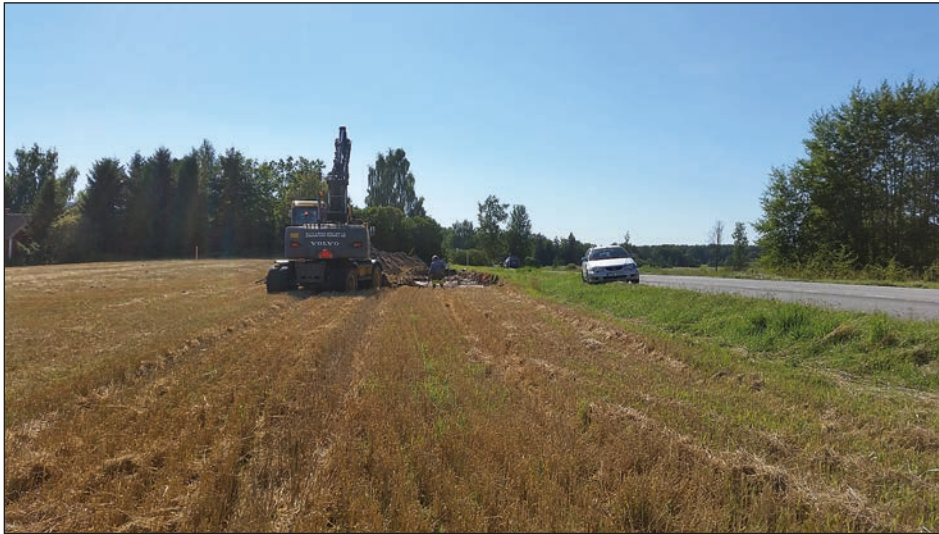
Figur 23. Vy över objekt 18Ö från öster. Foto av Leif Karlenby.
