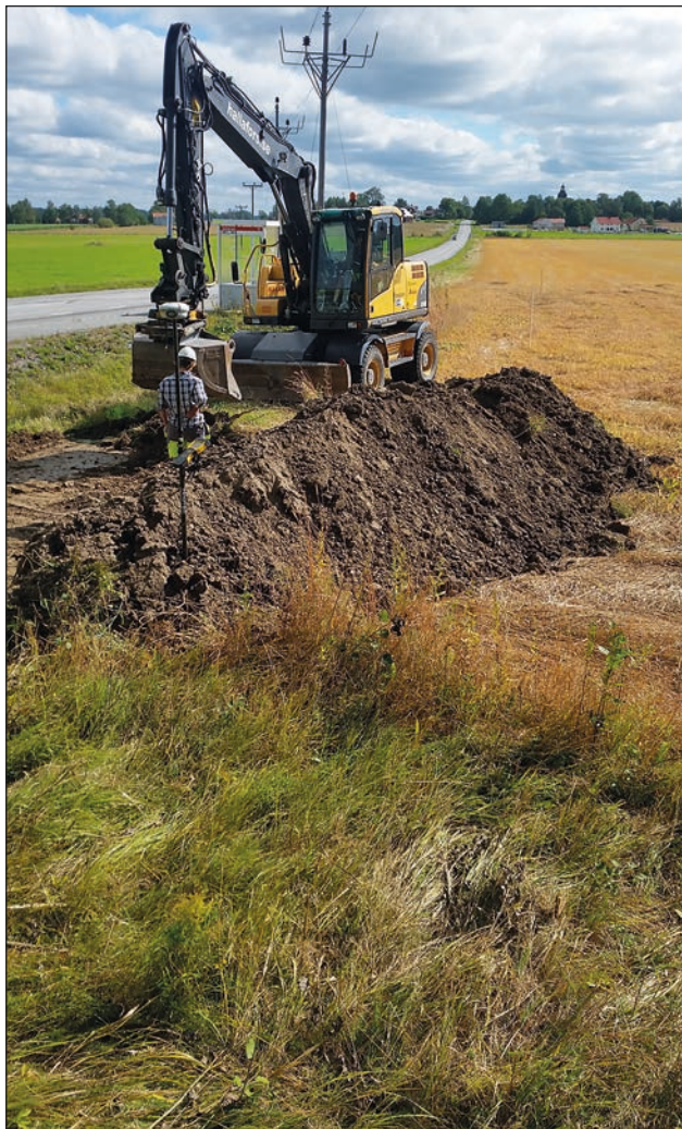
Figur 6. Schaktningen har precis påbörjats inom objekt 12. Foto från väster av Leif Karlenby.
