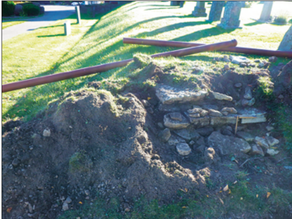
Figur 4. En trappa påträffades i schakt 4 och framrensades. Trappstegen av kalksten var i dåligt skick. Tidigare har trappor funnits på vardera sida av en öppning i kyrkomuren. Trapporna har lett upp till krönet på en terrasserad mur som vid senare tid blivit övertäckt med jord. Foto från norr av Johnny Rönngren.
