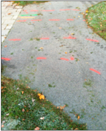
Figur 5. Cykelbana i undersökningsområdets södra del där underliggande kablar markerats på asfalten. Foto från norr av Tomas Ekman.
