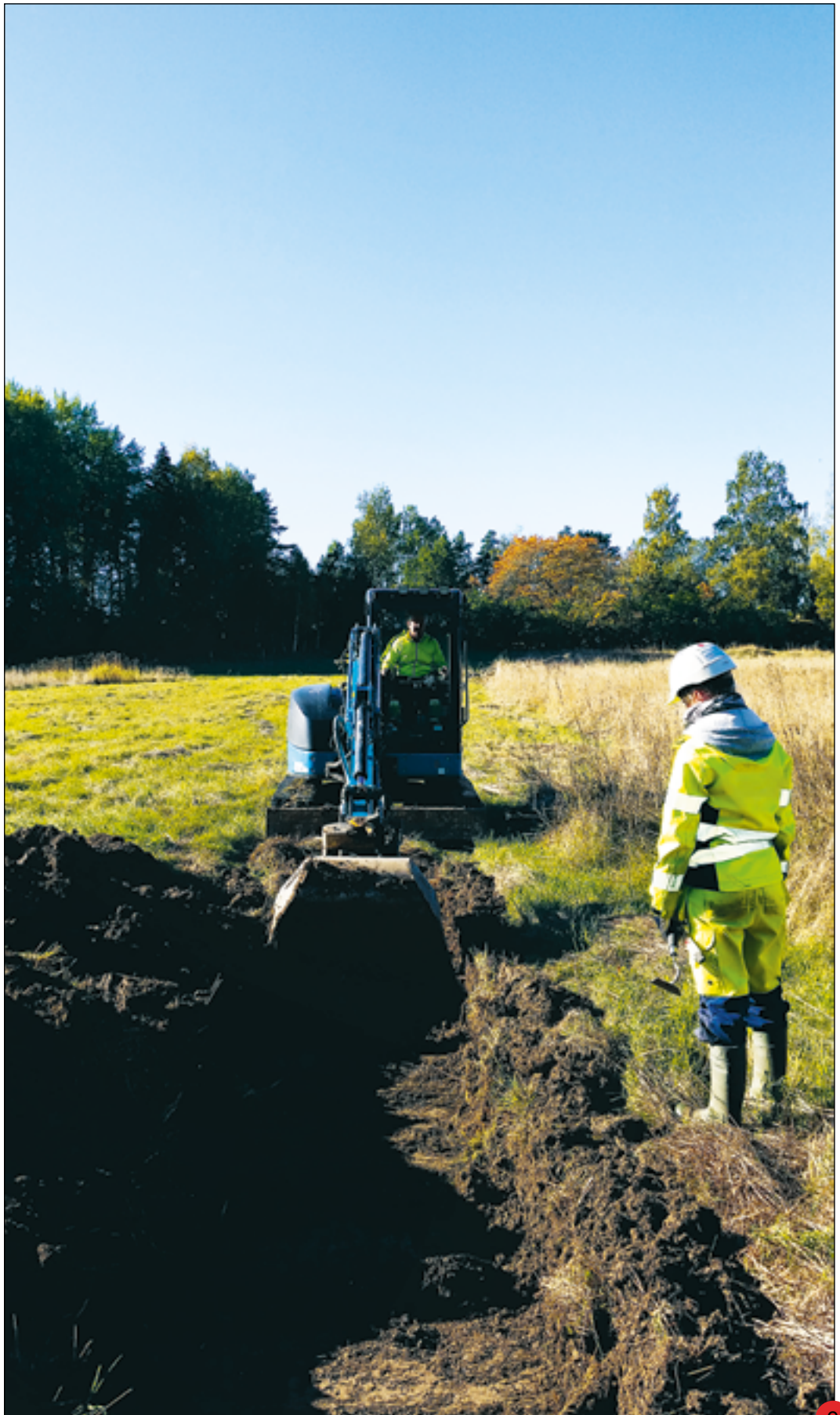
Figur 4. Schaktning längs en av vägsträckningarna. Foto från öster av Leif Karlenby.
