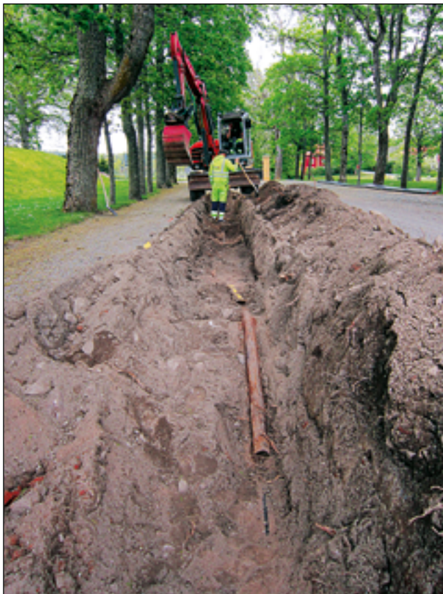
Figur 4. Schaktning pågår – i botten syns den befintliga kabeln. Foto av Tomas Ekman.
