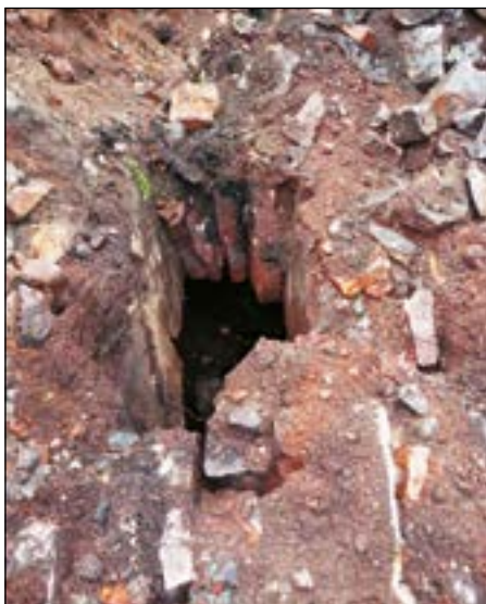
Figur 14. Hålet i det valvslagna taket (A900) som uppstod i samband med att schakt 366 skulle grävas. Foto från norr av Arkeologgruppen AB.
