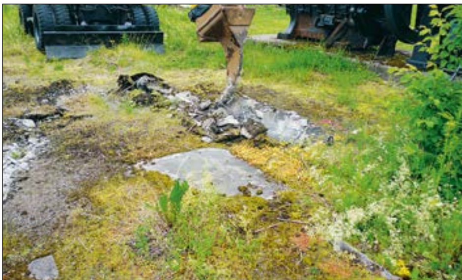
Figur 6. Det ovan omnämnda betonggolvet som behövde brytas upp innan schaktning kunde ske. Foto från sydväst av Arkeologgruppen AB.
