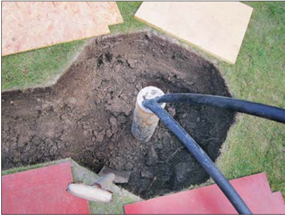
Figur 4. En mångsidig grop med installation för bergvärme. Foto av Caroline Ericsson.
