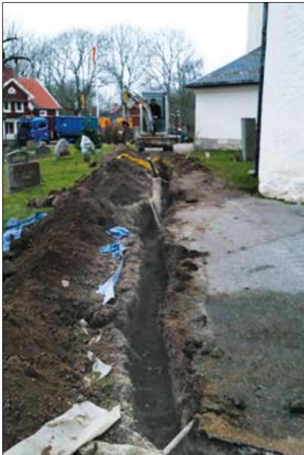
Figur 3. Det smala schaktet som grävdes för bergvärmeledningen. Foto från söder av Johnny Rönngren.
