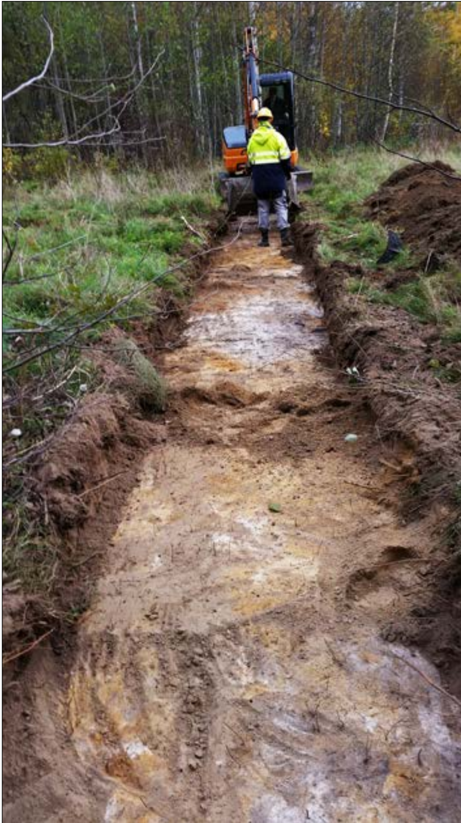
Figur 4. Söschakt dras i det västra utredningsområdet. Foto av Leif Karlenby.
