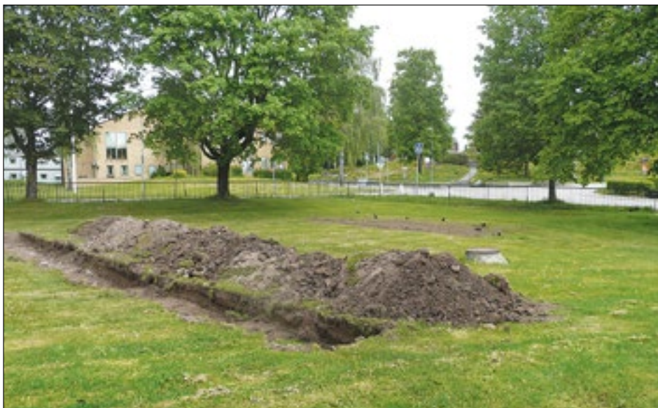
Figur 4. Översikt över schakt i nordöstra delen av området. I bakgrunden, på andra sidan gatan, syns fornlämningen Hallstahammar 290:1. Foto från sydväst av Leif Karlenby.
