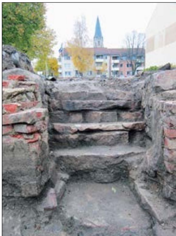
Figur 33. Detaljbild på trappans uppbyggnad sett från söder. Foto: Annica Ramström.
