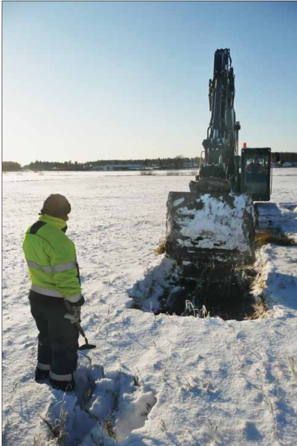
Figur 3. Schaktningen på Norrsunda 277 skedde i november när den första snön hade fallit. Temperaturen sjönk till -18°C och arbetet fick avbrytas för att fortsätta under våren 2011. Foto av Leif Karlenby.
